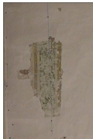
ZACHYCENÁ ŠABLONA PRO REKONSTRUKCI VÝMALBY
