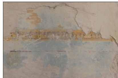
ZACHYCENÁ ŠABLONA PRO REKONSTRUKCI VÝMALBY
