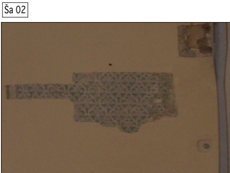
ZACHYCENÁ ŠABLONA PRO REKONSTRUKCI VÝMALBY
