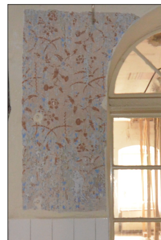
ZACHYCENÁ ŠABLONA PRO REKONSTRUKCI VÝMALBY
