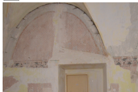
ZACHYCENÁ ŠABLONA PRO REKONSTRUKCI VÝMALBY
