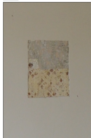
ZACHYCENÁ ŠABLONA PRO REKONSTRUKCI VÝMALBY
