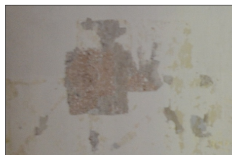
ZACHYCENÁ ŠABLONA PRO REKONSTRUKCI VÝMALBY
