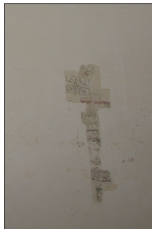
ZACHYCENÁ ŠABLONA PRO REKONSTRUKCI VÝMALBY
